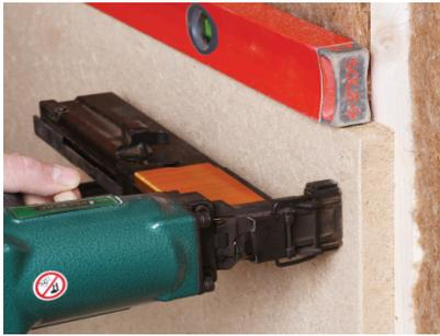
Bei Wänden wählen Sie bis zu 9-15 (22/16) und für Decken bis zu 15 Befestigungspunkte.
