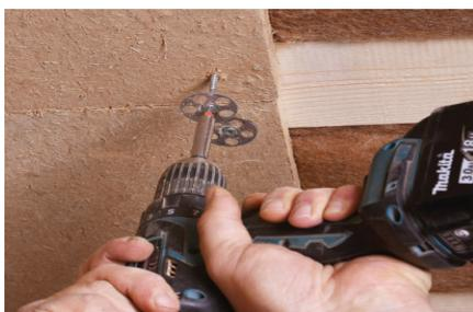
Die Platten werden an vertikalen Wänden mit Tellerkopfschrauben/Klammern und an horizontalen Decken und Dachschrägen mit Schrauben und Haltetellern befestigt.
