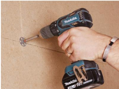
Die Tellerkopfschrauben (5x50) sollten bündig mit der Oberfläche der Lehmbauplatte abschließen.
