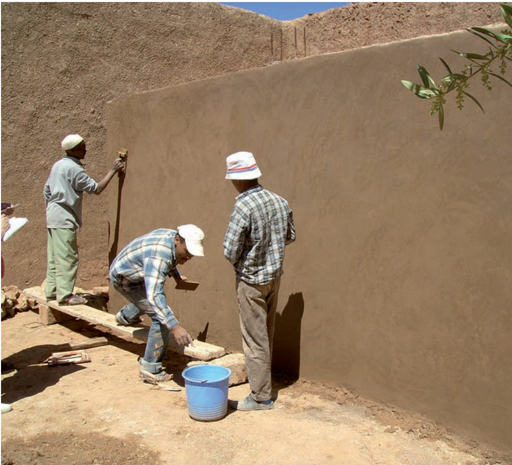
In Marokko wird das natürliche Vorkommen hydraulischen Muschelkalks genutzt. Meist arbeiten mehrere Männer an einer Wand. Foto: Alfred Proschinger
